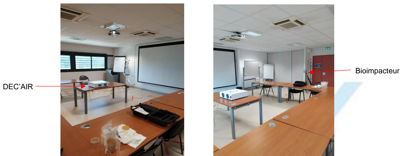
Figure 6: Disposition du bio-impacteur et du dispositif de désinfection dans la salle de réunion du BIC INNOV'UP (113m 3 )
